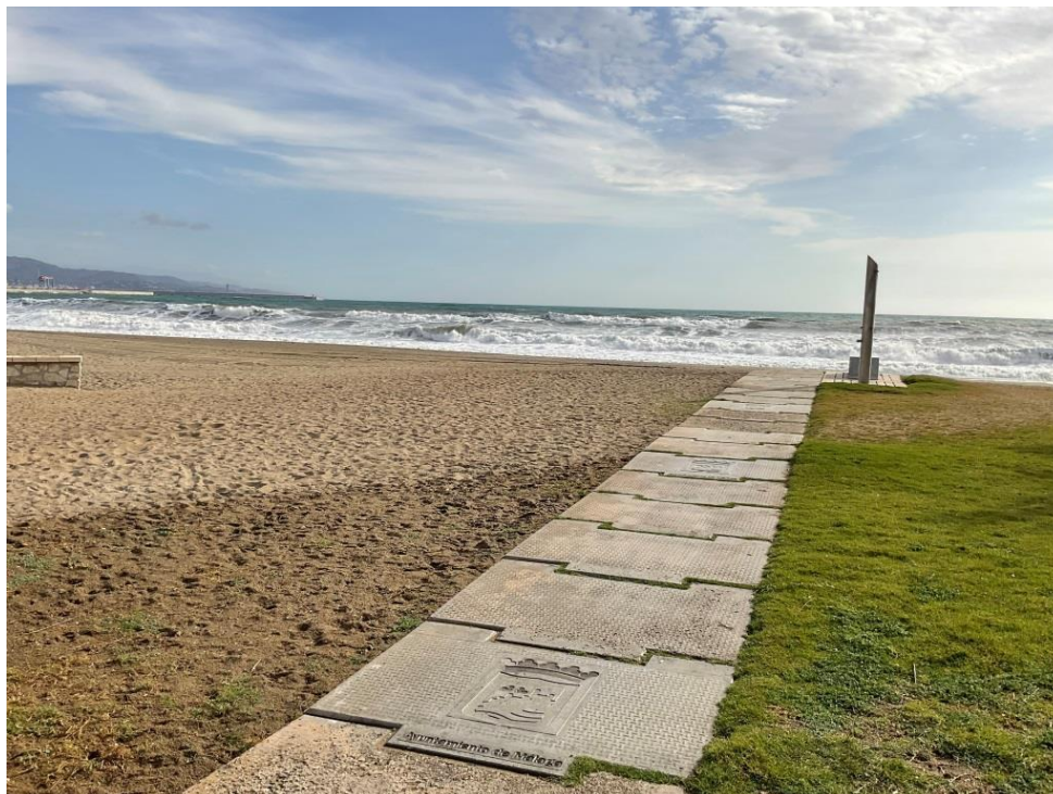
Ilustración 34. Pasarela de hormigón hasta la línea de agua en playa de La Misericordia
